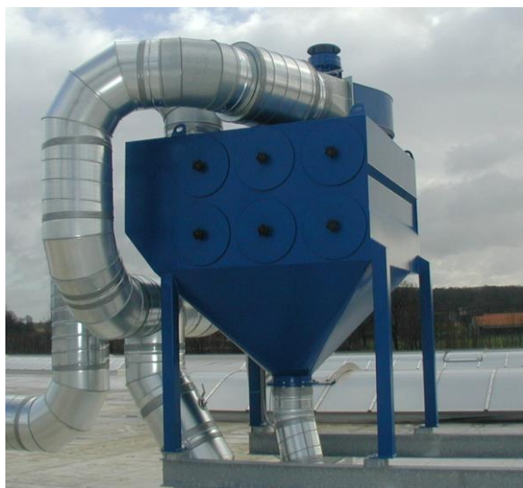
Stasjonært filteranlegg, kapasitet 22000 m 3 /h.
