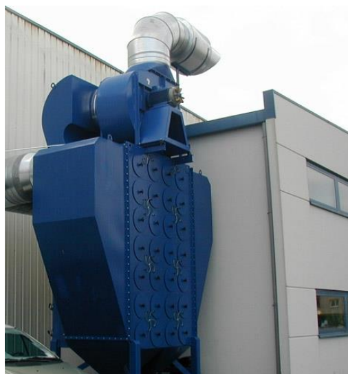
Filter med kapasitet på 100.000 m 3 /h.
